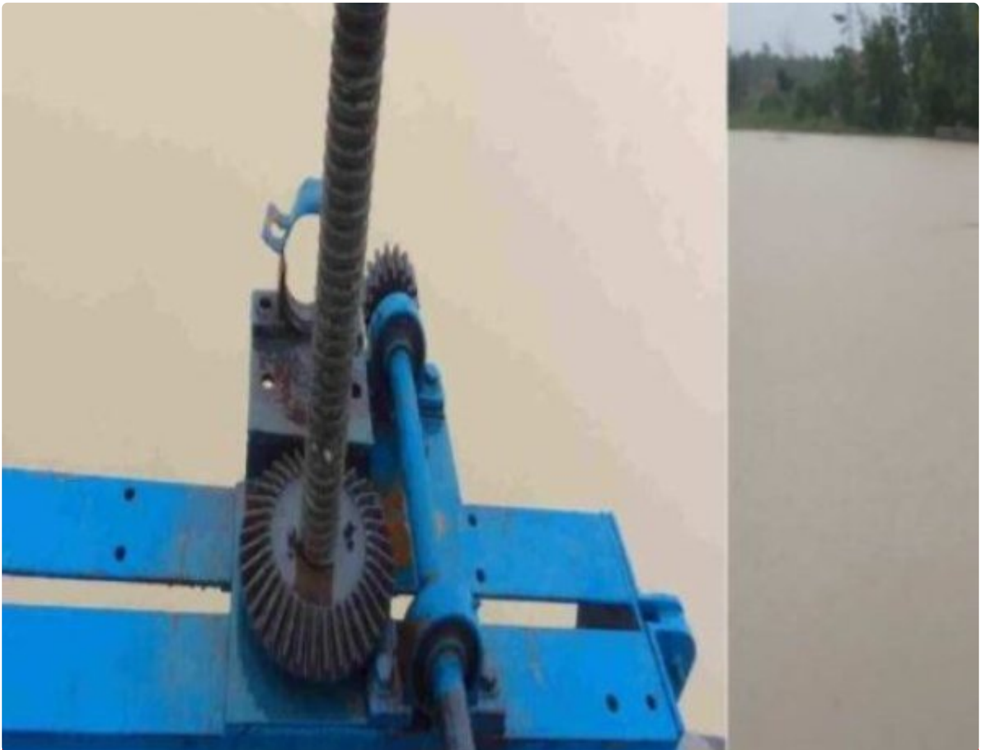
Pintu air Albaret Simpang Mesuji
